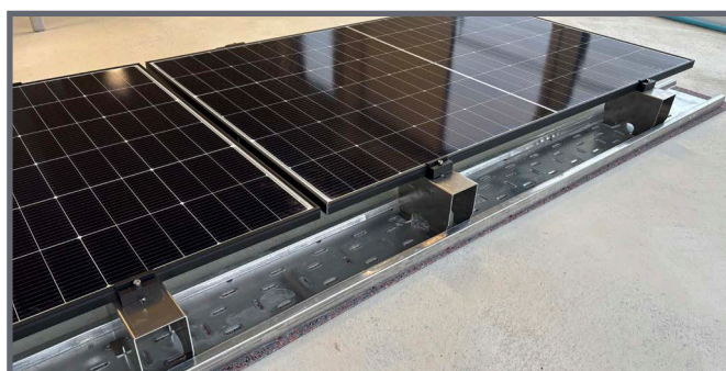
Première rangée de modules entièrement montée
