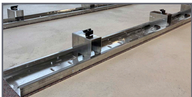
Supports de modules entièrement montés pour la première rangée de modules
