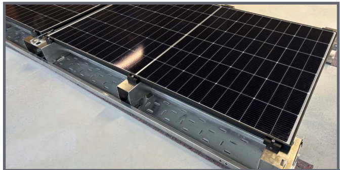
Première rangée de modules entièrement montée
