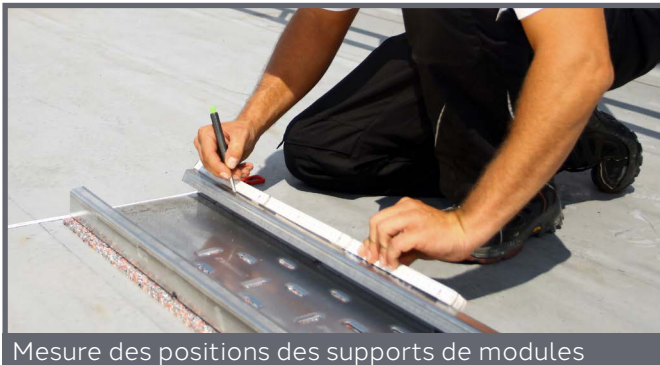
Mesure des positions des supports de modules
