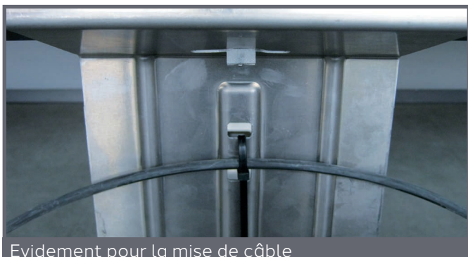
Evidement pour la mise de câble
