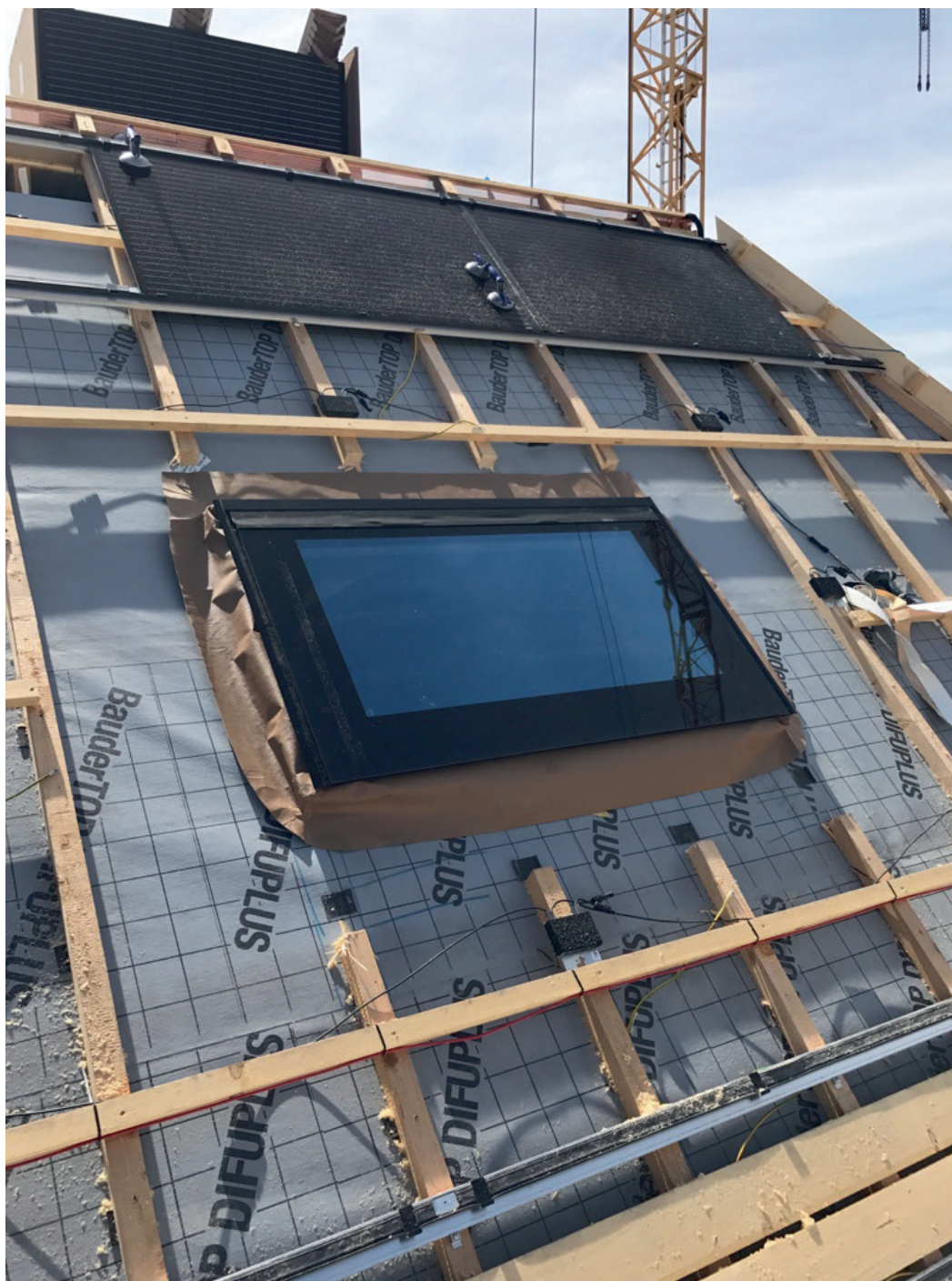
6. La fenêtre Wenger est insérée dans le cadre de contre-lattage à l'aide des vis de positionnement.
