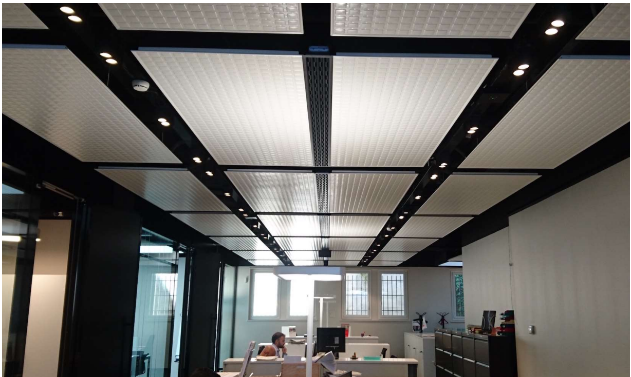
Fig. 12 – Caisson de diffusion d'air intégré dans un groupe de panneaux climatiques Kigo
