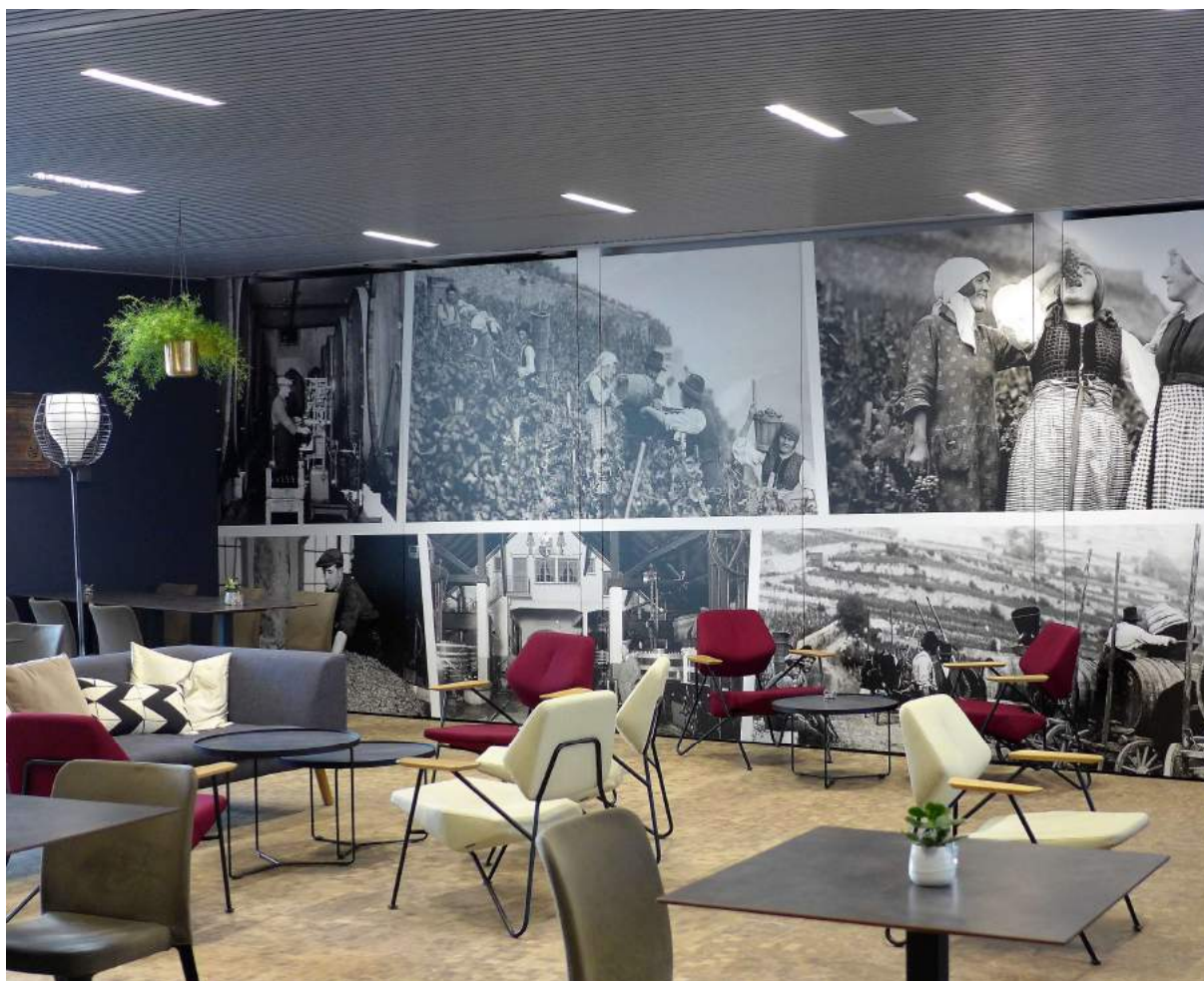
Faux plafond en lames acoustiques métalliques micro-perforées
