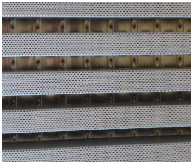
Lames acoustiques en métal micro-perforé.
