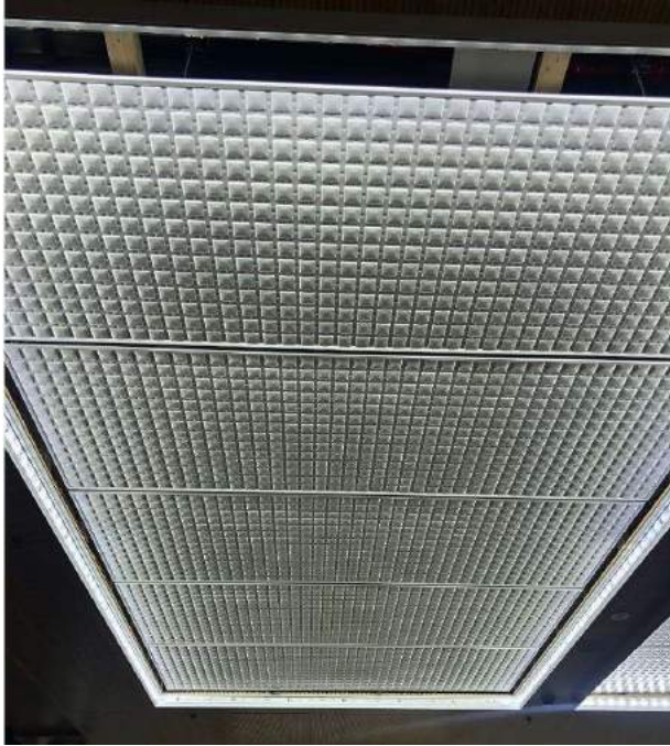
Îlot avec échangeurs KIGO et luminaires intégrés avant la pose de la toile tendue – Ecole hôtelière de Lausanne
