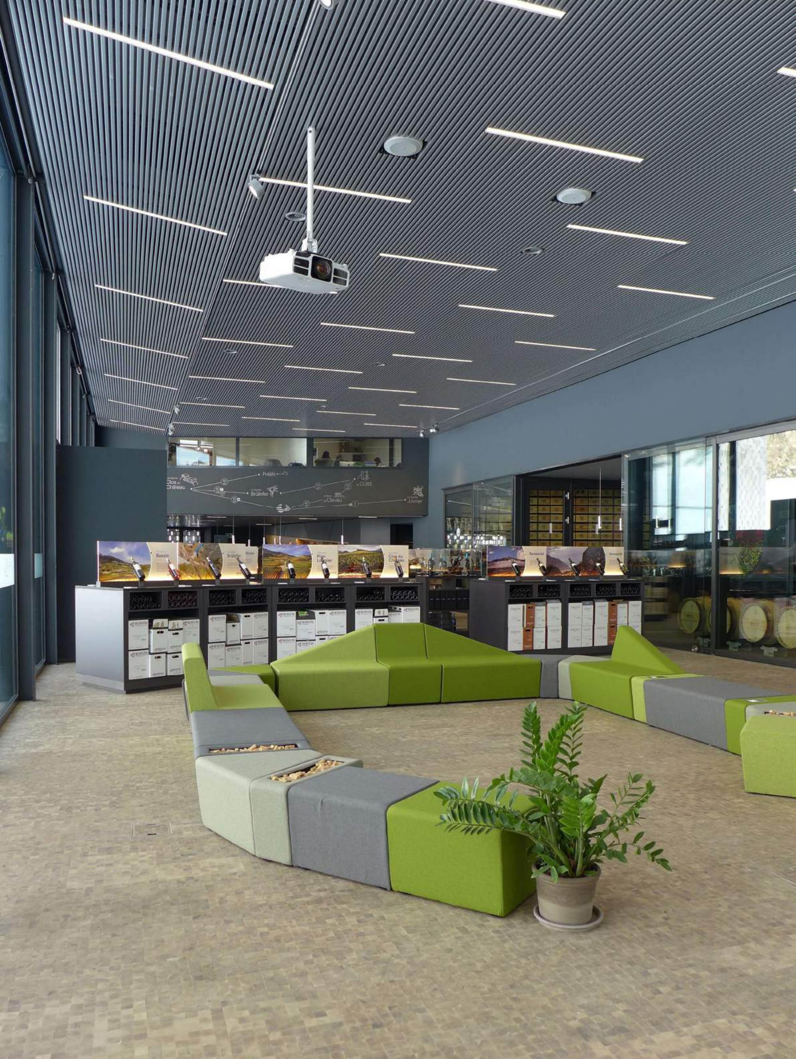
Lames acoustiques en métal micro-perforé (Les Celliers de Sion)
