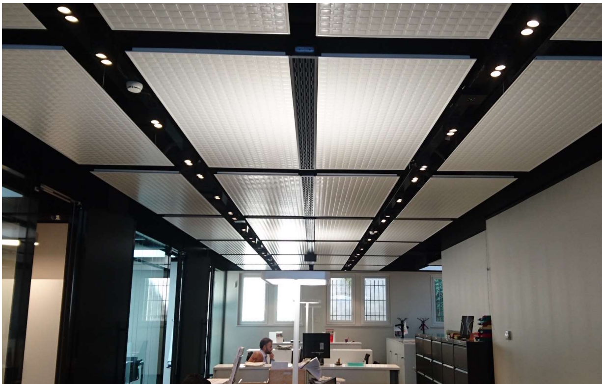
Fig. 12 - Kombination der Frischluftauslässe und Lüftungskanäle mit KIGO Klimadecken
