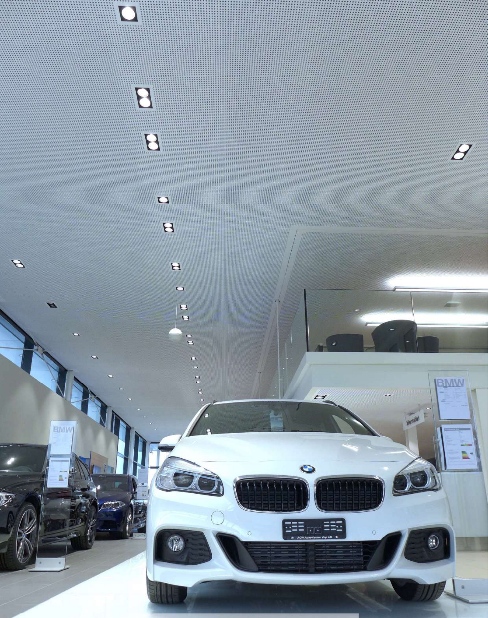
Perforierte Gipsdecke mit Akustikflies (ACW Auto-Center Visp AG)
