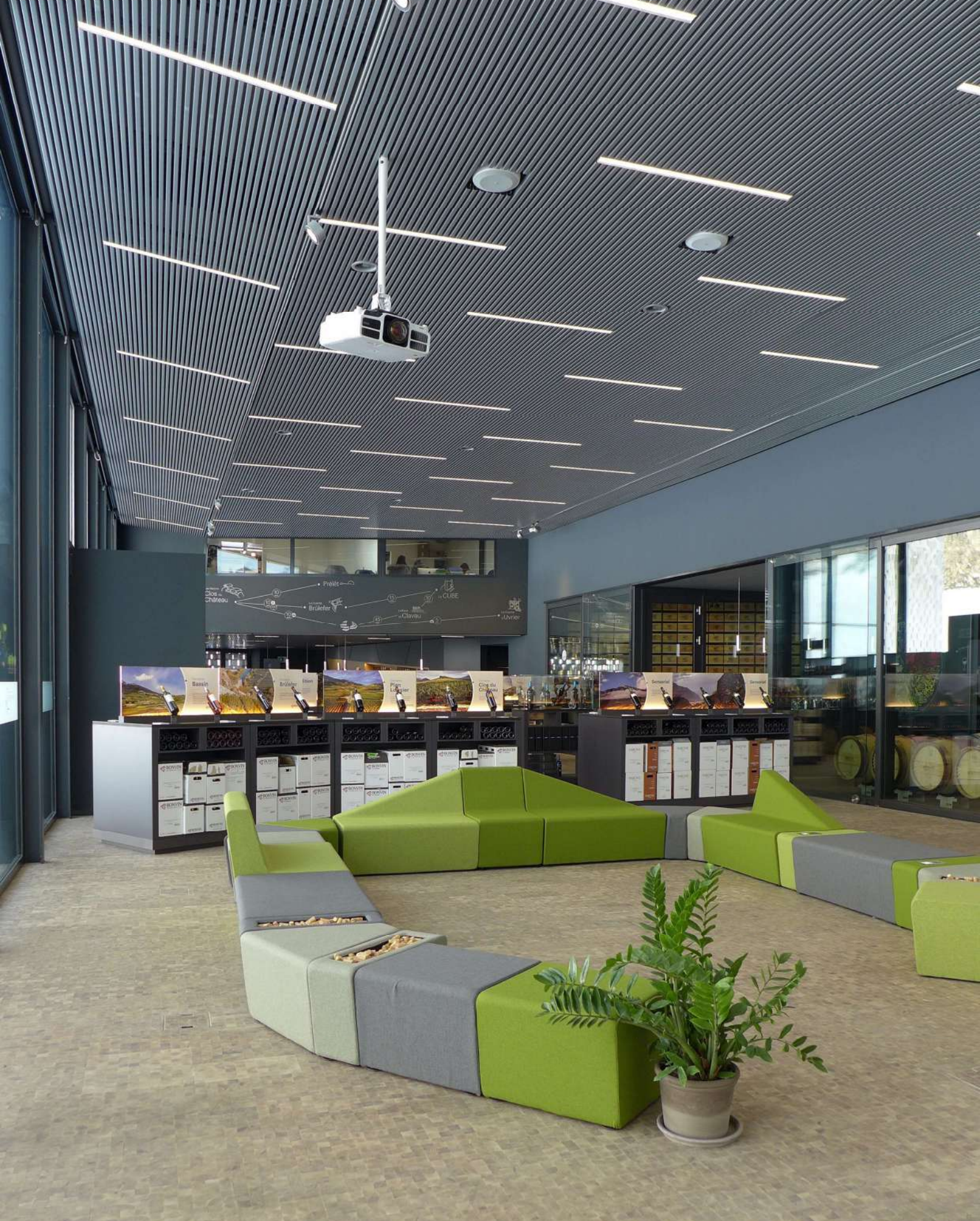
Akustiklamellen aus micro-perforiertem Metall (Les Celliers de Sion)
