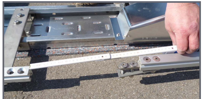
Fehlende Pass-Stucke ausmessen und zuschneiden
