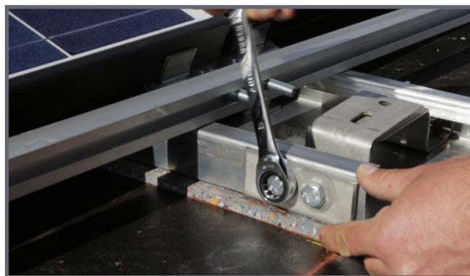
Lastverteilungsblech ansetzen und Schrauben eindrehen!
