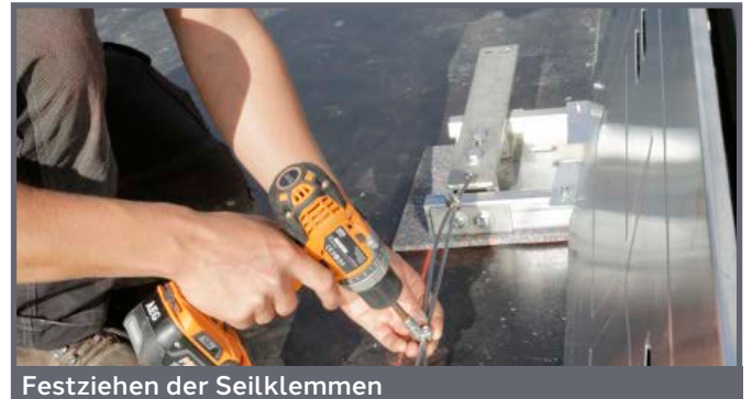
Seilsystem zur Lasteinleitung in das System
