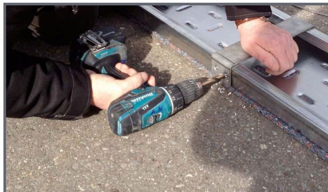
Mit Bohrschablone Löcher in Bodenschiene setzen
