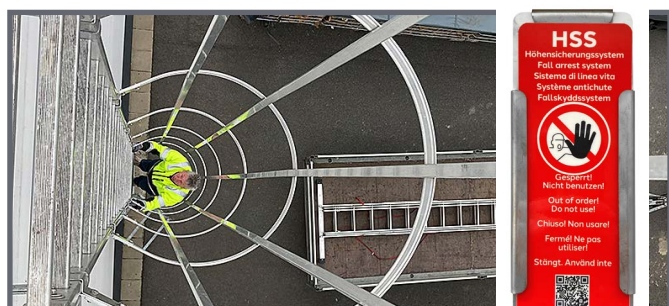
Das Warnschild muss am Dachzugang angebracht sein.
