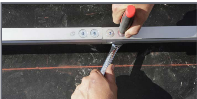
Schieneverbinder mit den vier Senkkopfschrauben
