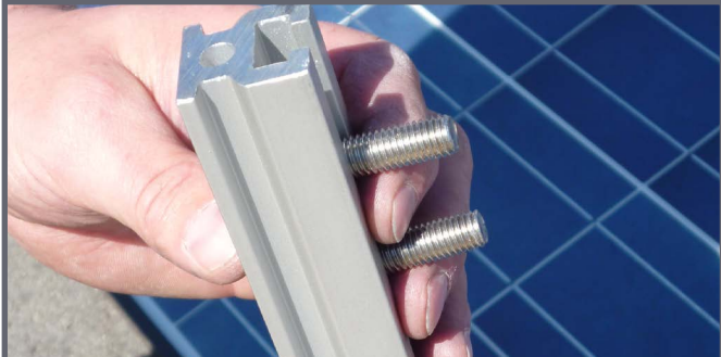
Einführen der Schrauben in die Laufschiene
