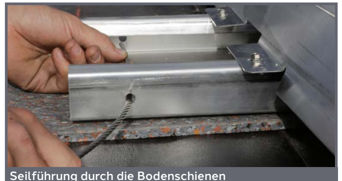
Seilführung durch die Bodenschienen
