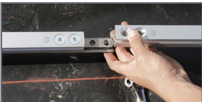
Verbinden der Laufschiene
