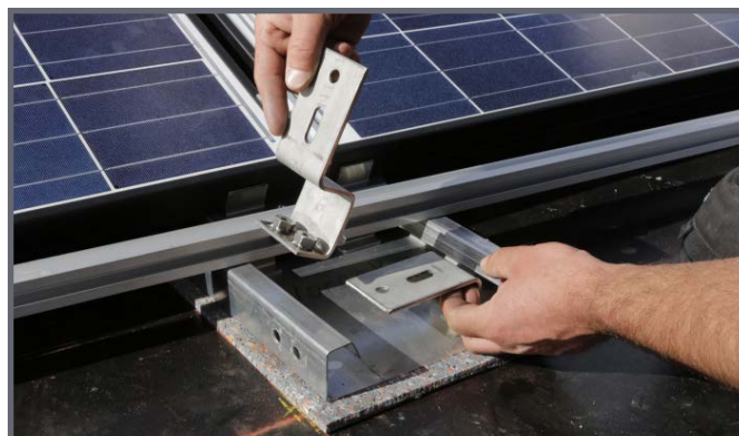
Vorderen Befestigungspunkt in Bodenschiene setzen
