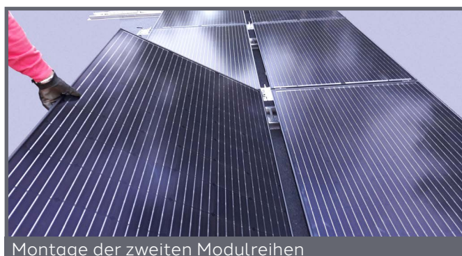
Fertig montierte erste Modulreihe
