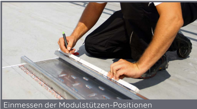
Einmessen der Modulstützen-Positionen
