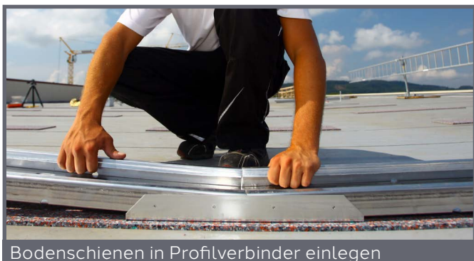
Bodenschienen in Profilverbinder einlegen
