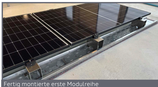
Fertig montierte Modulstützen für die erste Modulreihe
