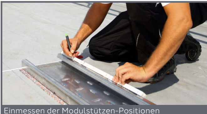
Bodenschiene als Kabelkanal für die Stringkabel genutzt
