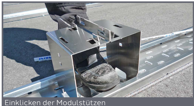
Einklicken der Modulstützen
