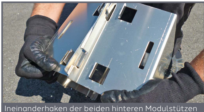
Ineinanderhaken der beiden hinteren Modulstützen
