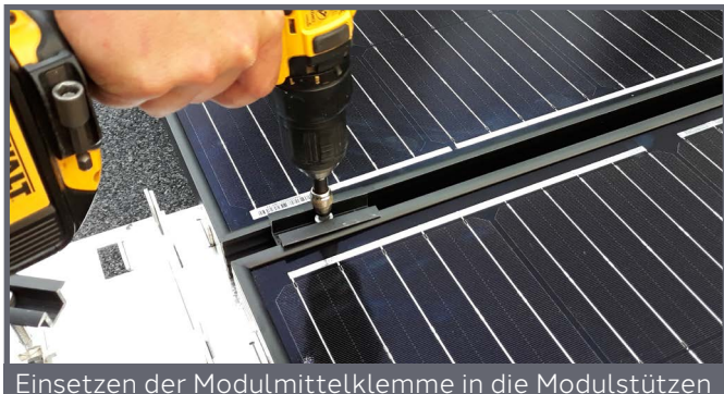
Einsetzen der Modulmittelklemme in die Modulstützen
