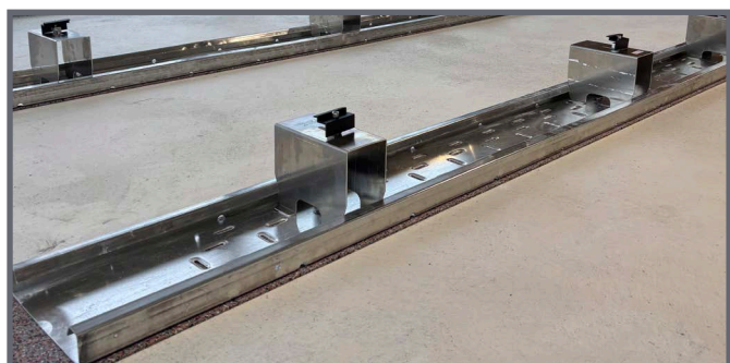
Fertig montierte Modulstützen für die erste Modulreihe
