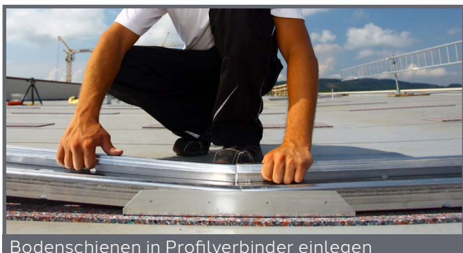
Bodenschienen in Profilverbinder einlegen
