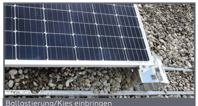
Ballastierung/Kies einbringen
