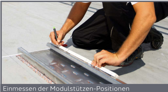
Einmessen der Modulstützen-Positionen
