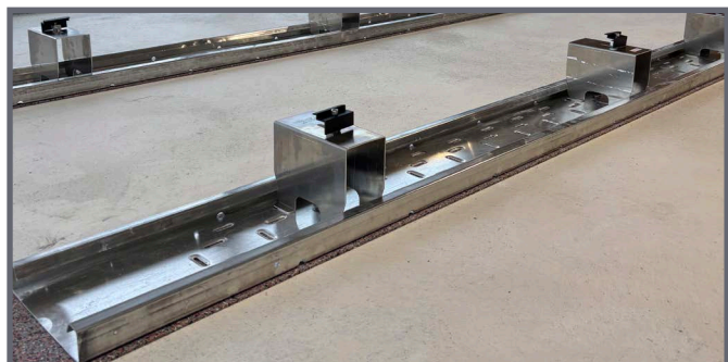
Fertig montierte Modulstützen für die erste Modulreihe
