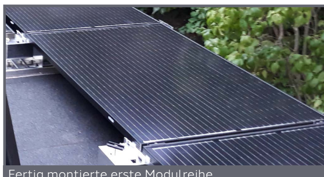
Fertig montierte erste Modulreihe
