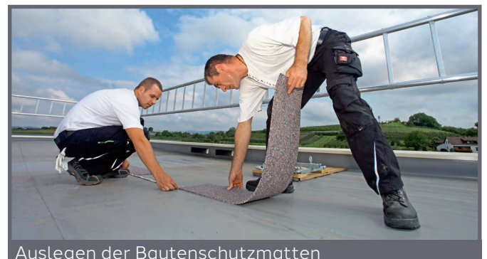
Auslegen der Bautenschutzmatte
