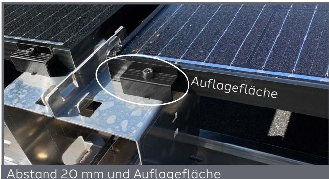
Auflegen des Photovoltaik-Moduls
