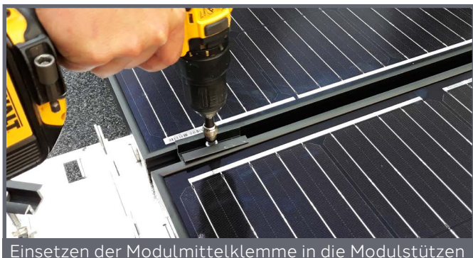
Einsetzen der Modulmittelklemme in die Modulstützen
