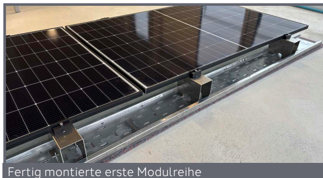
Fertig montierte Modulstützen für die erste Modulreihe
